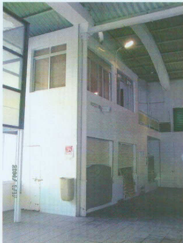
Entrepanta de oficinas municipales
