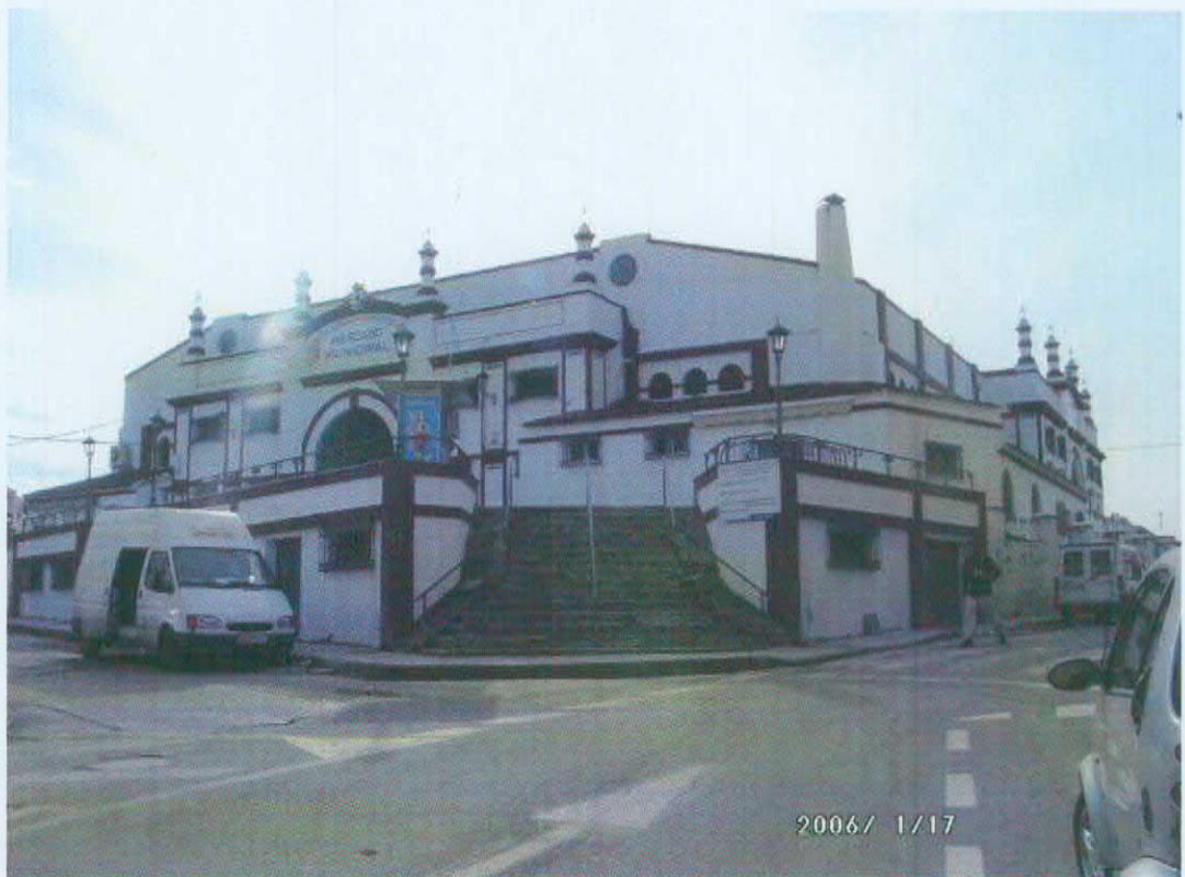
Esquina Calle de las Viñas con Calle Cantones. Área de descarga de pescado
