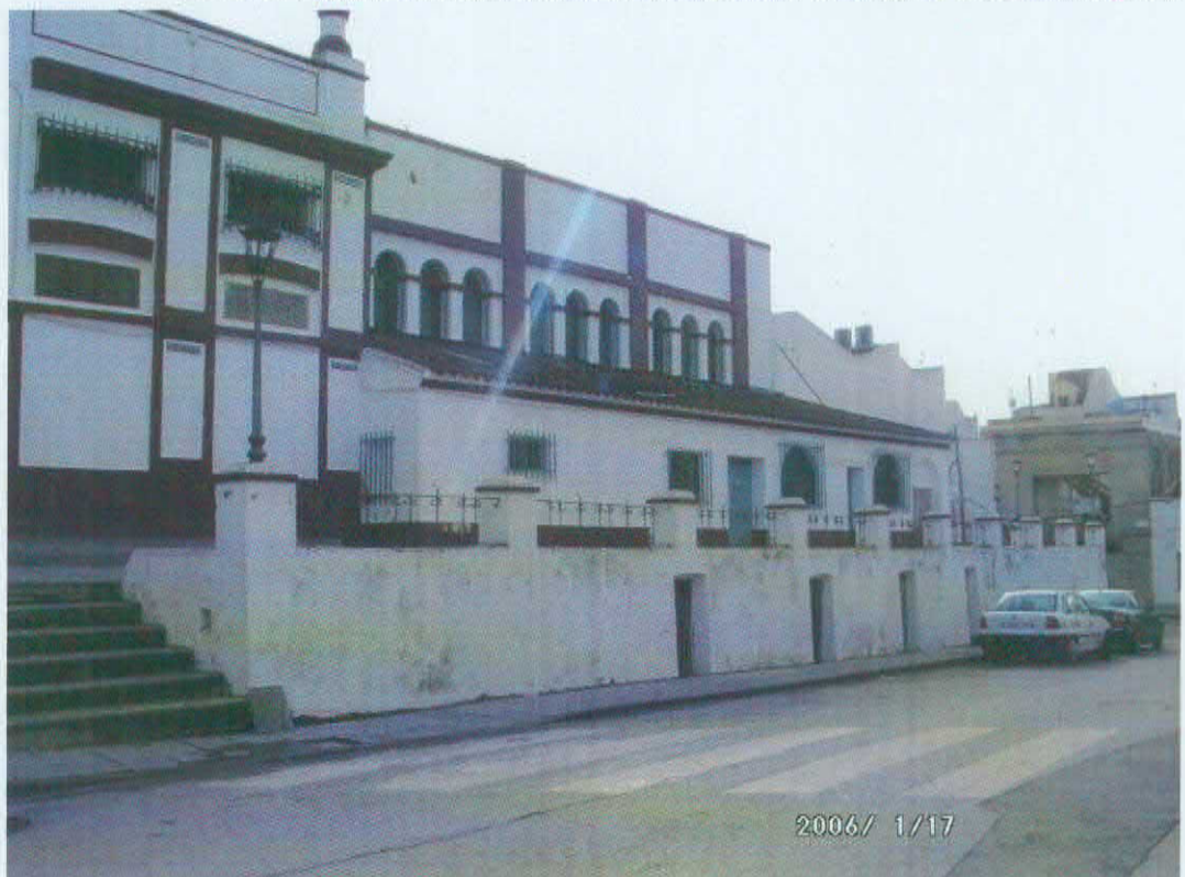
Zona de almacenes exteriores en la Calle Cantones en desuso
