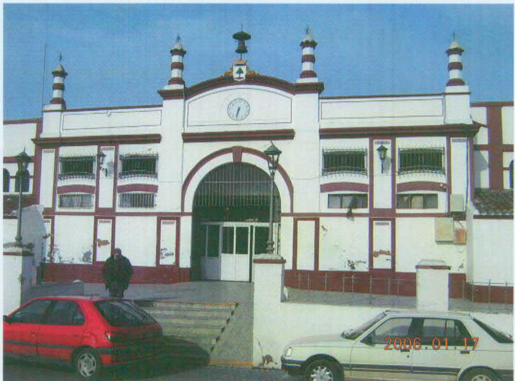
Acceso desde la Explanada. Principal puerta de entrada de carne.
